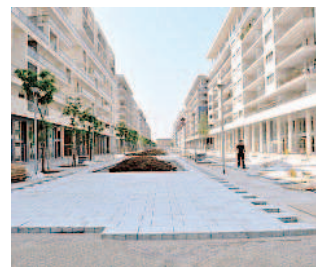
L'area-cantiere a Montecity
